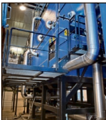
SVENSK: Den massive fyrkjelen er levert av svenske Hotab, og det nye rørrettet er lagt av danske Dan Svejs. Foto: Morten Høitomt
