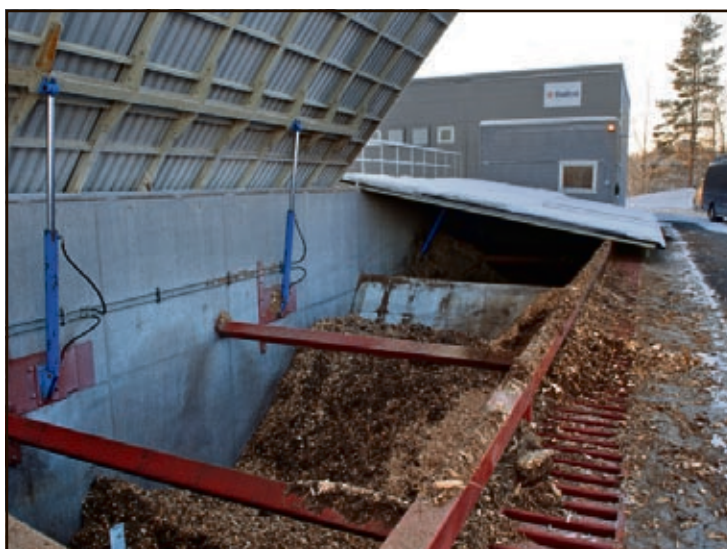
BRENNES: Anlegget forbruker 80–90 tonn flis hver dag. Foto: Morten Høitomt
